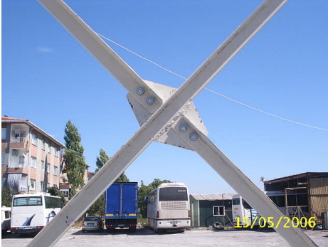
Resim 2.10, Resim 2.11: Kolon-çaprazlama birleşimlerinde bulon sayılarının gözle kontrolü
