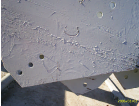
Resim 1.45-46: Kalın vurulan boya ve kurumadan yapılan istiflemeyen kaynaklanan hatalar
