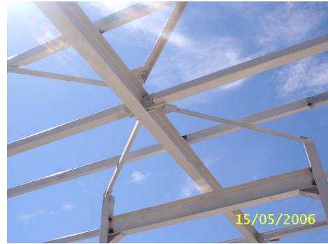
Resim 2.12, Resim 2.13: Kiriş-rüzgarlık birleşimlerinde bulon sayılarının gözle kontrolü
