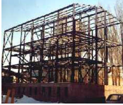
Resim 2.2:Projenin taşıyıcı iskeletinin tamamlanmış hali
