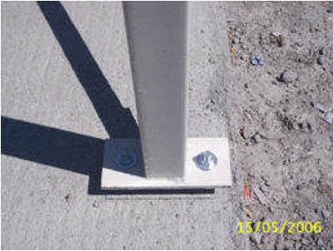
Resim 2.5: Kolon ebatlarını kontrol etmek.
