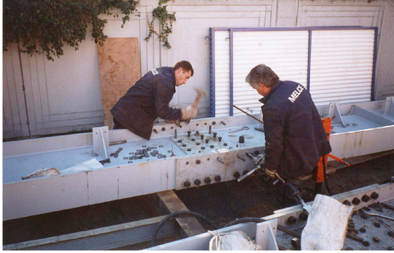
Resim 1.36: Bulonların tabancayla sıkılması
