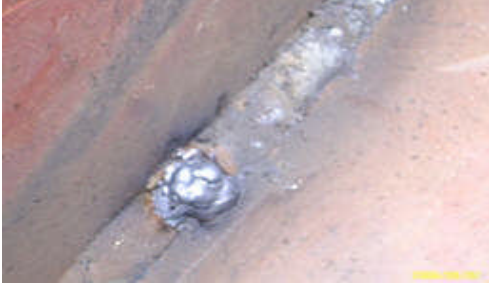
Resim 1.28 :Kaynak öbeklenmesi
