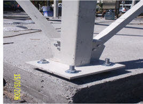
Resim 2.6: Kolon taban kotlarının Kontrolü
