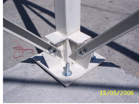
Resim 2.10, Resim 2.11: Kolon-çaprazlama birleşimlerinde bulon sayılarının gözle kontrolü
