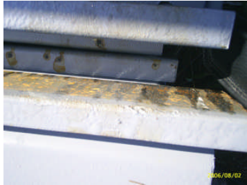
Resim 1.39-40: Boyanın kurumadan yağmur veya neme maruz kalması sonucu oluşan korozyon
