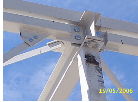
Resim 2.8, Resim 2.9, Kolon-kiriş birleşimlerinde bulon sayılarının gözle kontrolü
