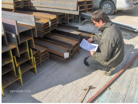
Resim 1.6: Malzemenin sipariş formuna göre kontrolünün yapılması
