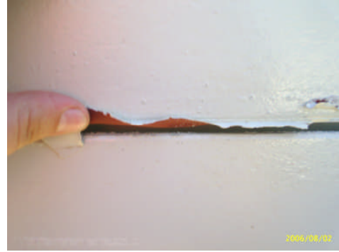
Resim 1.47-48: Yüzey temizliği iyi yapılmamış malzeme
