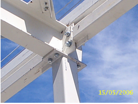
Resim 2.8, Resim 2.9, Kolon-kiriş birleşimlerinde bulon sayılarının gözle kontrolü
