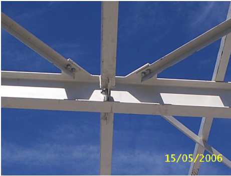
Resim 2.12, Resim 2.13: Kiriş-rüzgarlık birleşimlerinde bulon sayılarının gözle kontrolü
