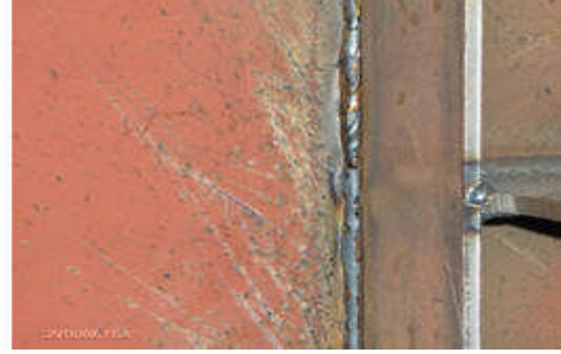
Resim 1.31: Üst kabuğu kaldırılmamış ikinci kat kaynak uygulaması
