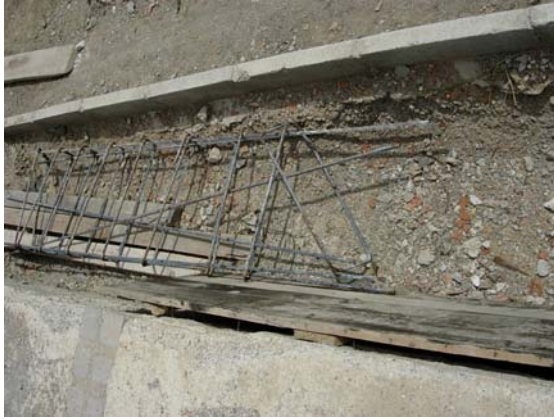
Fotoğraf 3. Kırılan kolonun hasar vermeden çıkarılan donatısı.
