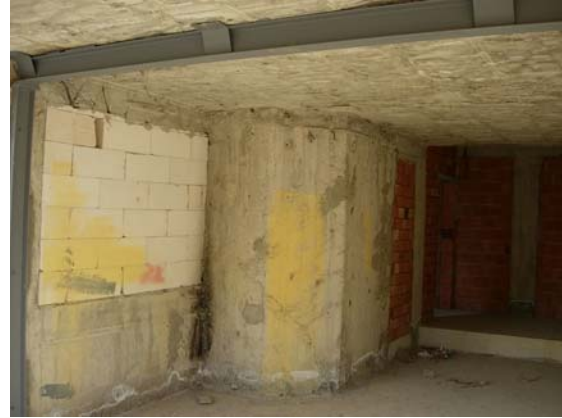
Fotoğraf 7. Çelik konstrüksiyonla yapılan güçlendirme.
