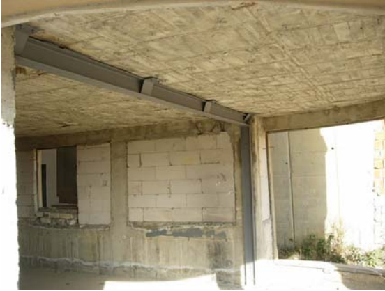
Fotoğraf 6. Çelik konstrüksiyonla yapılan bir güçlendirme örneği.
