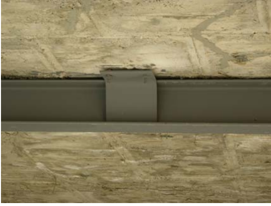
Fotoğraf 8. Yapılan güçlendirmede döşeme bağlantıları.
