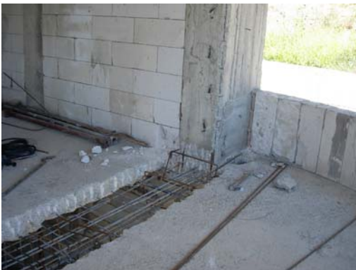
Fotoğraf 16. Fotoğraf 6 ve 7 de gösterilen çelik konstrüksiyon yerine yapılan güçlendirme
