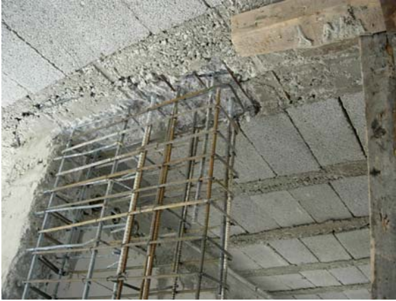
Fotoğraf 11. Kırılarak ilave yapılan bir kolon.
