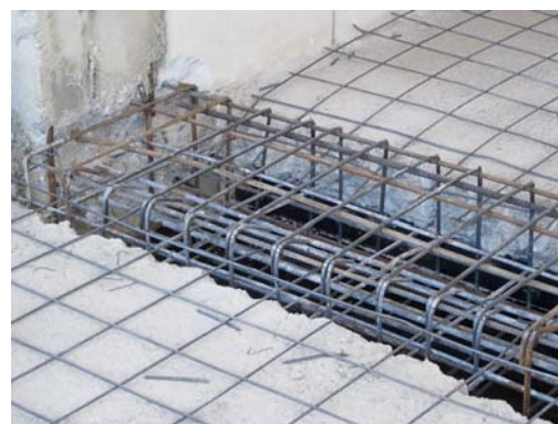
Fotoğraf 17 Fotoğraf 6 ve 7 de gösterilen çelik konstrüksiyon yerine yapılan güçlendirme
